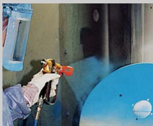
6 Окраска стальных деталей
